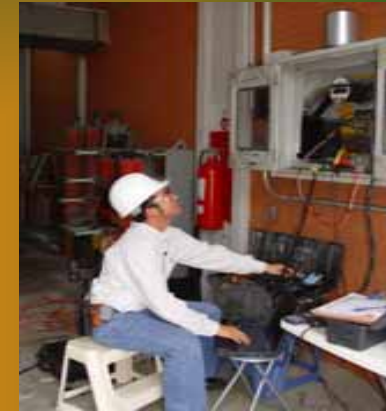
Calibración de medidores de energía de estado sólido en usuarios de alta tensión
