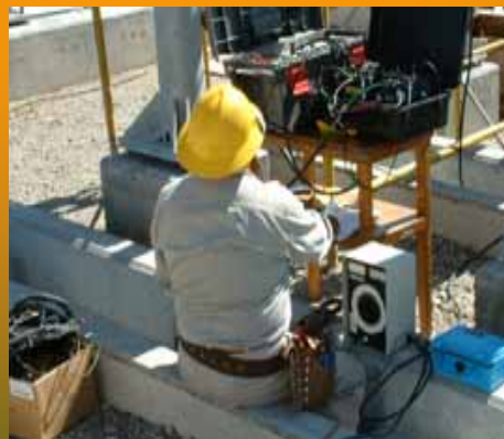
Pruebas de relación de transformación de Potencial
