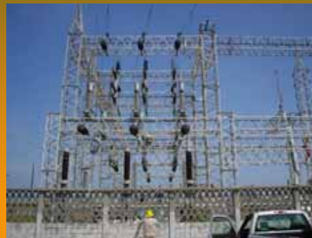
Medición de Usuarios en alta Tensión
