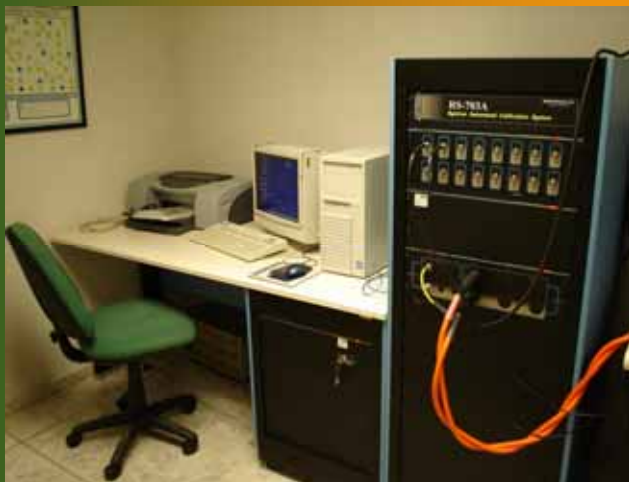
SISTEMA RADIAN RESEACH RS-703 A
