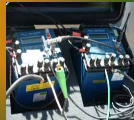
Prueba de relación a transformadores de corriente
