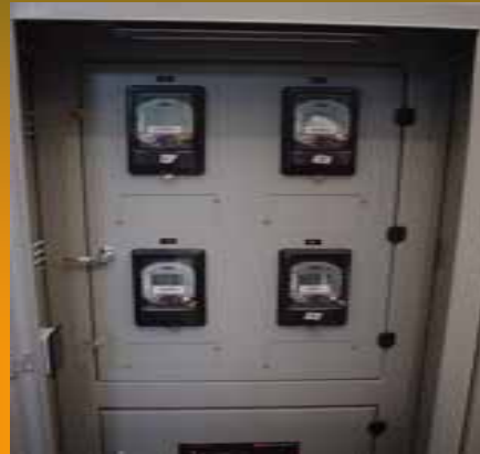
Calibración y verificación de Medidores de energía de estado sólido en circuitos de subestaciones de distribución.
